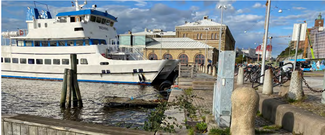
Figur 28 Lägre parti av kajen mellan svängbron och den renoverade kajen. Kajkant, gatsten och pollare i granit. (Norconsult, 2024)
