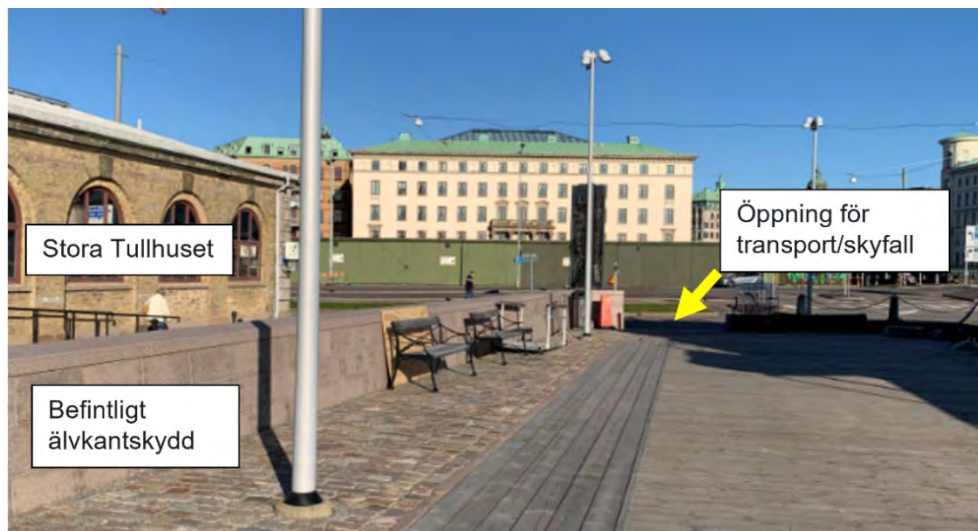
Figur 49 Gatubild föreställande älvkantskydd längsmed Packhusgatan. Gul pil markerar öppning för transporter och skyfall.
