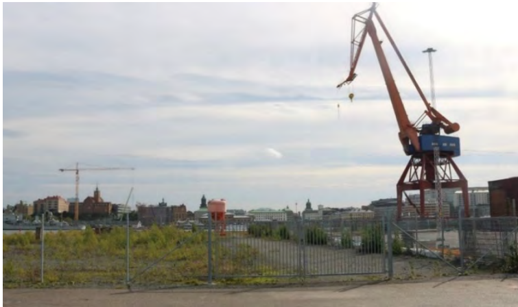
Figur 30 Vy från Lundbyvassen, Stapelkajen med bevarad portalvippkran i förgrunden. I bakgrunden framträder Göteborgs karaktäristiska stads-siluett, med Kvarnberget till vänster, Stora Tullhuset och Packhusplatsens bebyggelse centralt i vyn. (Norconsult, 2024)
